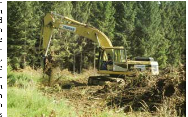
Auch bei starken Eingriffen in den Landlebensraum wie hier bei der Räumung von Baumstubben kann es zu großen Verlusten kommen
